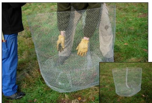
**Figure 3 :** Rabattre le fond du cylindre et introduire un carré de treillis d'1 m de côté par l'intérieur pour fermer le panier.
